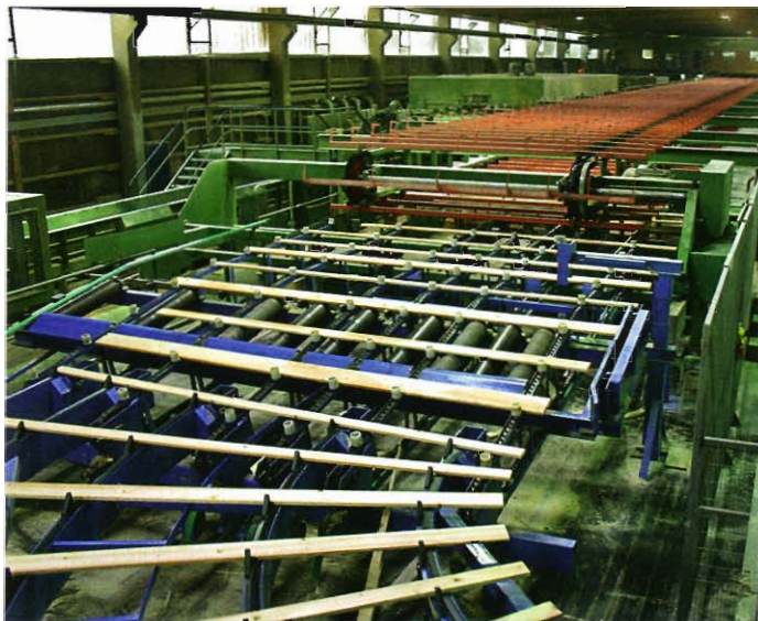
Auch der Bogenförderer und der obere Sortierstrang wurde im Zuge des Umbaus erneuert
