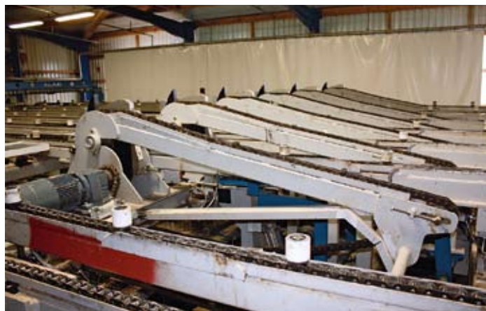
Bei stärkeren Dimensionen werden Kettenbänder hochgefahren und die Ware über den Tong-Loader transportiert
